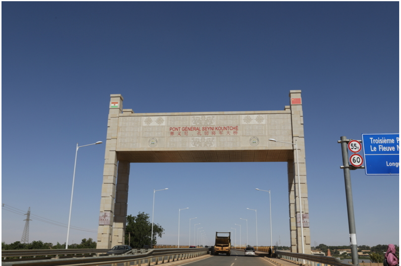
Ponte Generale Seyni Kountché, realizzato dai cinesi, inaugurato nel 2022, Niamey, Niger. Foto Marco Bello
