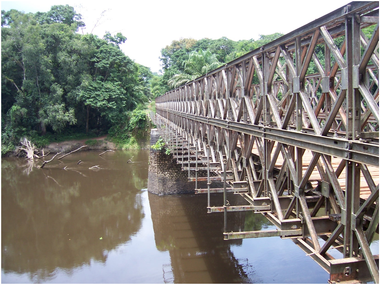
ponte sul fiume Nepoko, affluente del Congo – Foto Virgilio Pante
