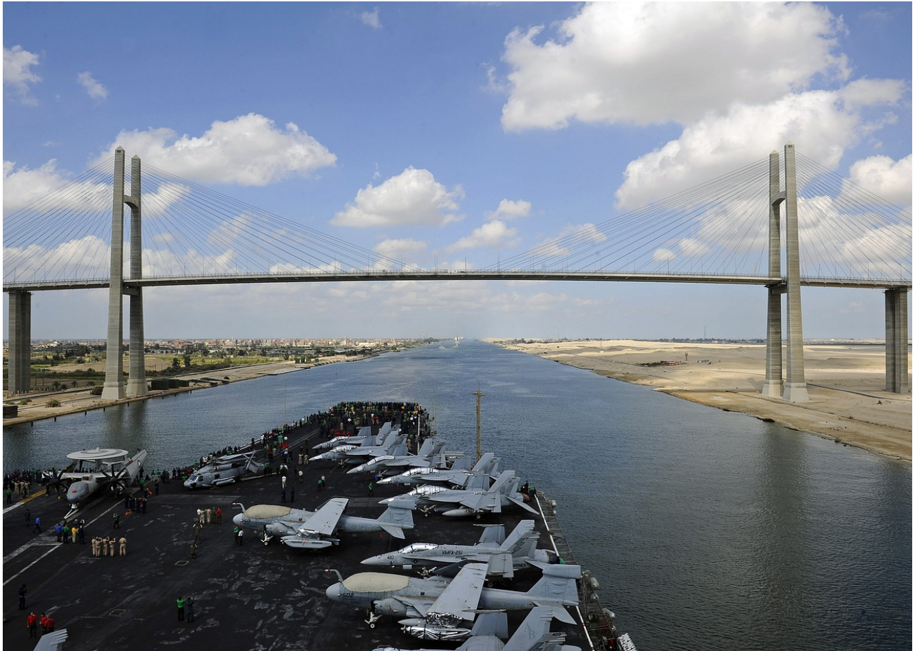
Il Canale di Suez attraversato da una portaerei (Foto da Pixabay).
